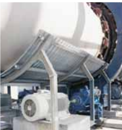
Drehofen-Doppelantrieb mit Planetengetriebe.
