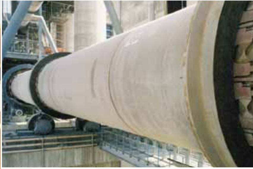
Drehofen auf 3 Rollenstationen gelagert.
