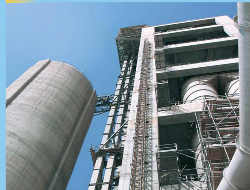
5stufige DOPOL® '90/PREPOL®-AS-Vorwärmer/Calcinator-Kombination in Saudi-Arabien; für eine Tagesproduktion von 3.500 Tonnen Grauzementklinker ausgelegt.
