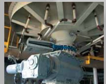
Konus und Auslauf des Multizellensilos.
