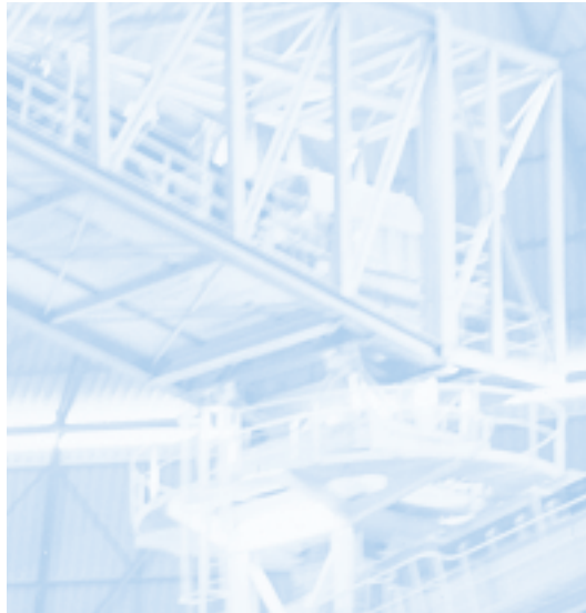
Kohlelager mit Kegelschalen-Aufschüttung: mit 25 m \varnothing – das kleinste bislang ausgeführte Lager.
