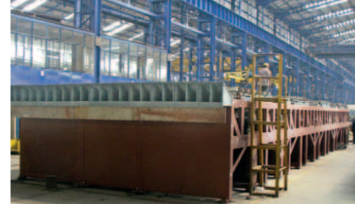
Montaje de módulos POLYTRACK® para un enfriador de 7.000 t/día.
