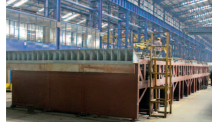
Montage de modules POLYTRACK® pour un refroidisseur de 7000 t/j.
