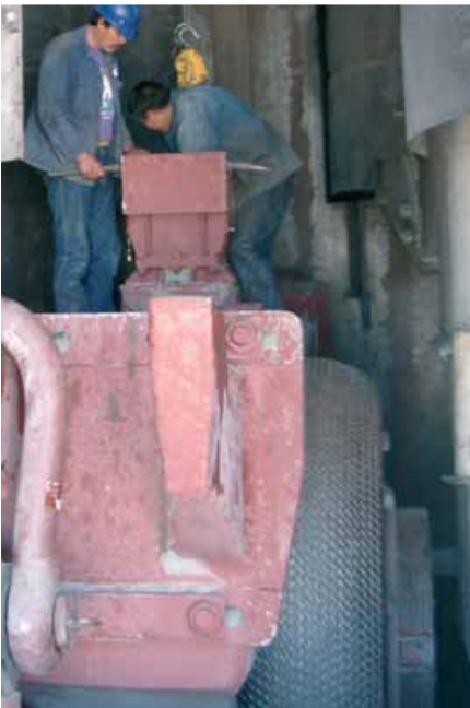
Blick in das Mühleninnere während der Montage.
