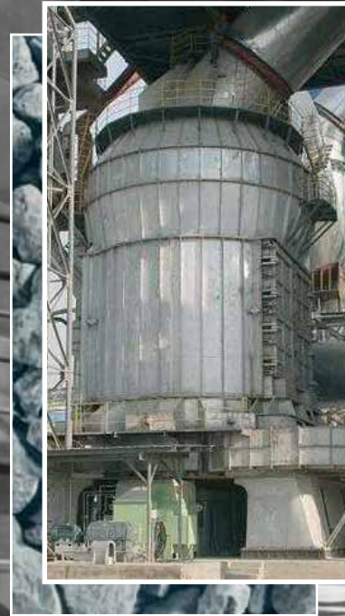
Broyeur à galets de cru en Chine.
