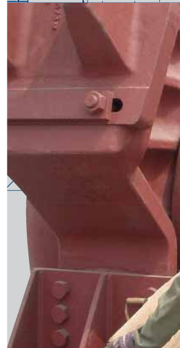
Montage d'un broyeur à galets de laitier en Chine.
