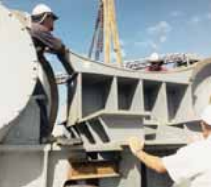
Монтаж печи POLRO®.
