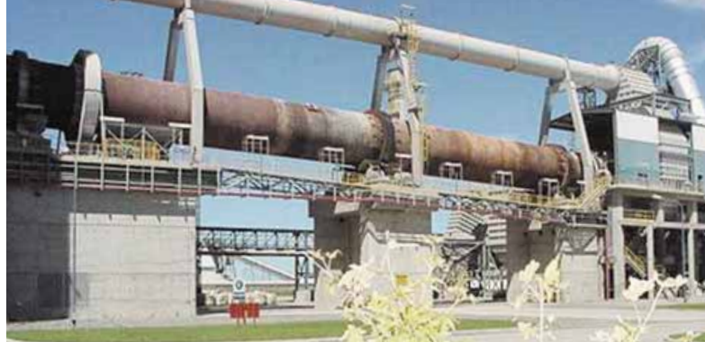
Печная система с 3-х опорной печью в Аргентине.
