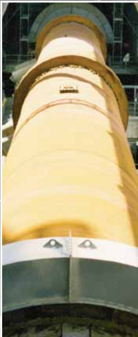
Печь с тремя опорами производительностью 5000 тон клинкера в сутки.
