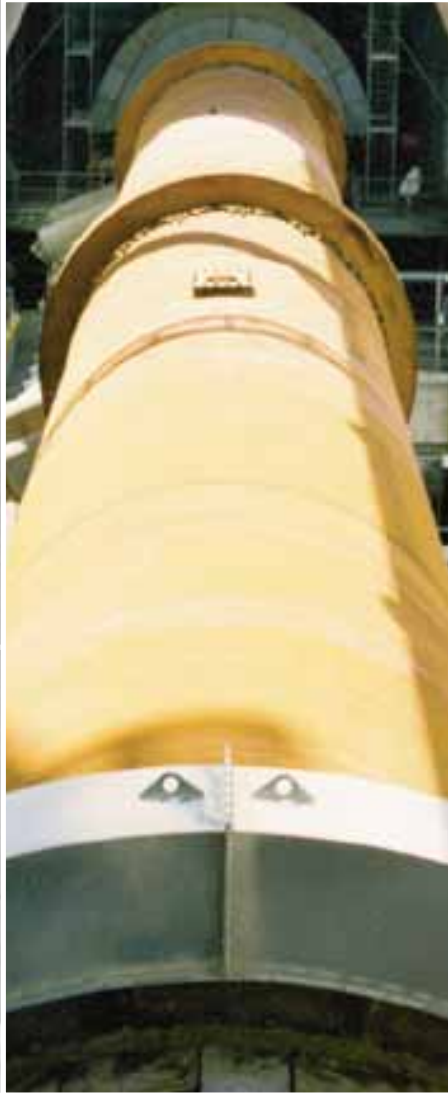
Ligne de production de 5.000 t/j de clinker sur trois stations de roulement.
