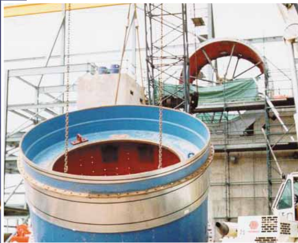
Montaje de un molino de bolas con cilindro abridado.
