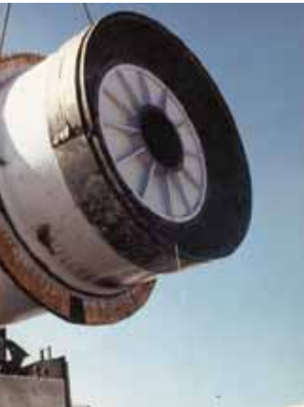
Montaje de un cilindro de molino de una sola pieza.
