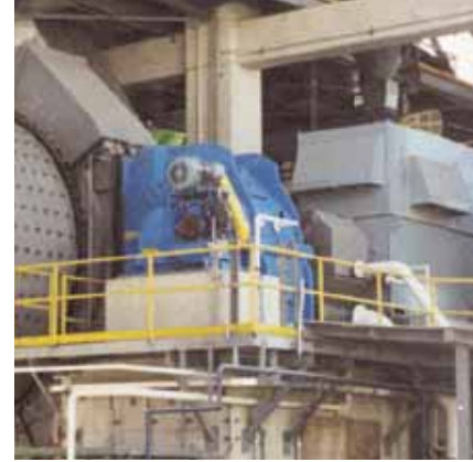
Accionamiento COMBIFLEX® (5.400 kW) con motor síncrono de alta velocidad y acoplamiento hidráulico.
