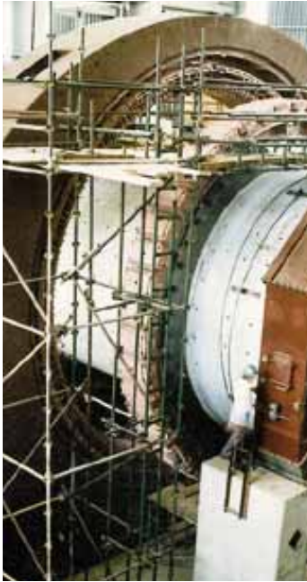
Instalación de un motor de anillos en un molino semi-autógeno.
