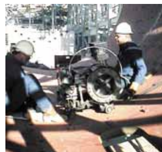
Soldadura en obra de grandes cilindros de molino.
